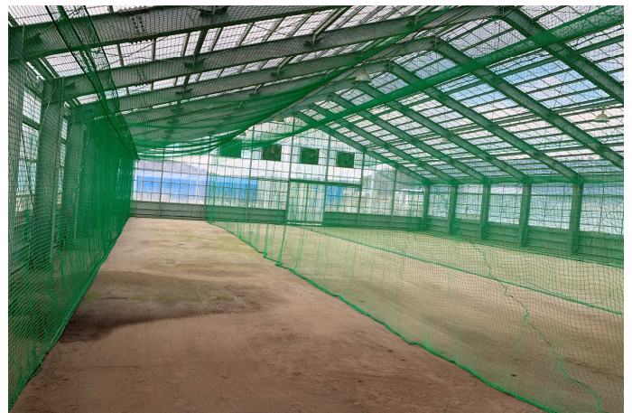
室内練習場ネット&仕切りカーテンネット施工
