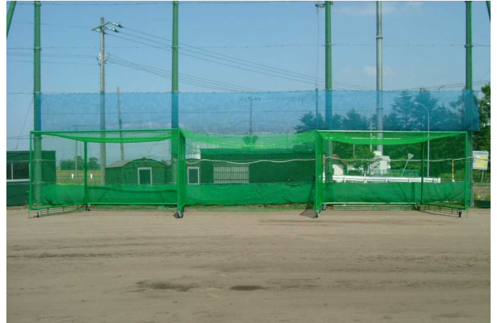
3連バッティングゲージ製作設置
