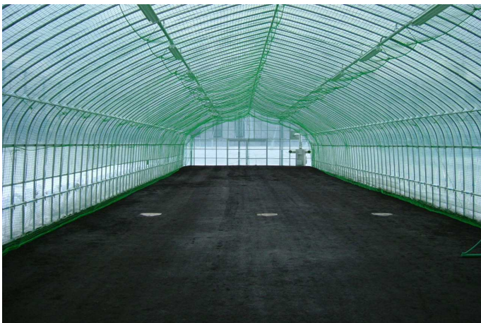
ビニールハウス室内練習場施工
