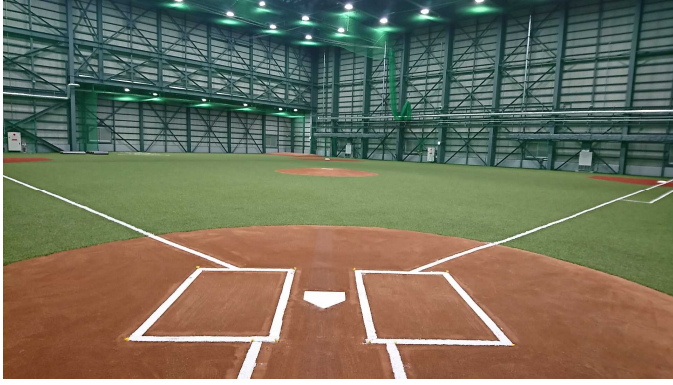
室内練習場ネット&人工芝新設施工
