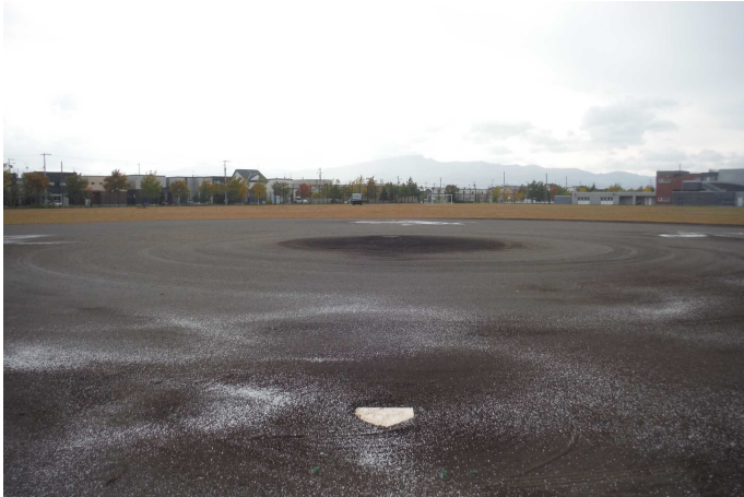
グラウンド整備及びマウンド整形施工
